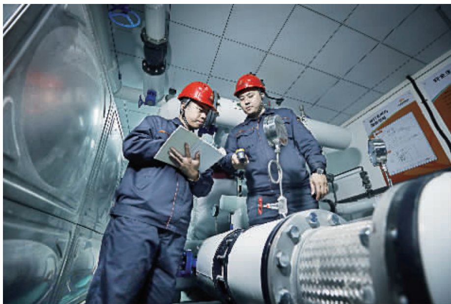
工作人员检查供热设施运行情况。
